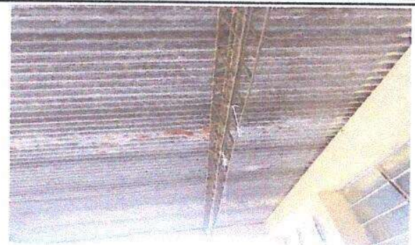
Foto 2: sustitución de estructura de soporte
