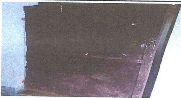
Foto 3: Mantenimiento a estructura (lijado, cambio de tubo, cepillado, sujeciones)
