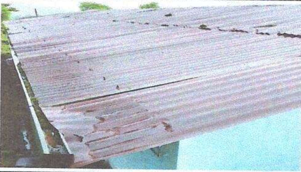
foto:1 Sustrucción de lámina y sustitución de capote
