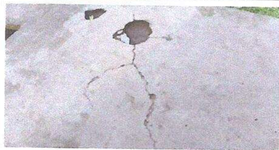
Foto 6: Reparación de banqueta de concreto
